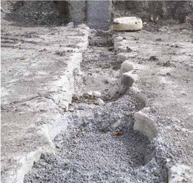
3. La realizzazione della prima fila di pali secanti in calcestruzzo alveolare
