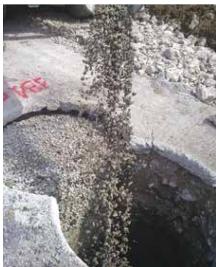
13. La realizzazione del palo drenante secante (fase B)
