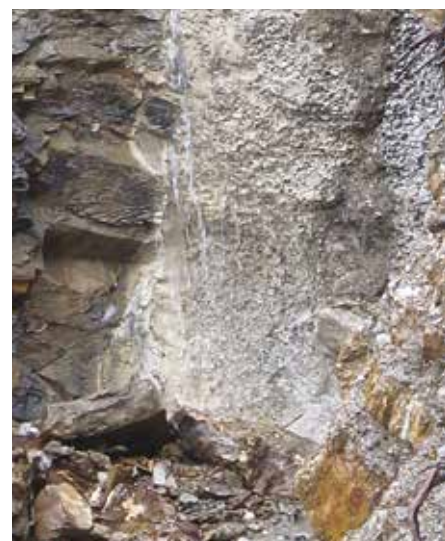
14. L'allontanamento delle acque drenate nel tratto terminale della paratia drenante prima dell'esecuzione del pozzetto di fondo
