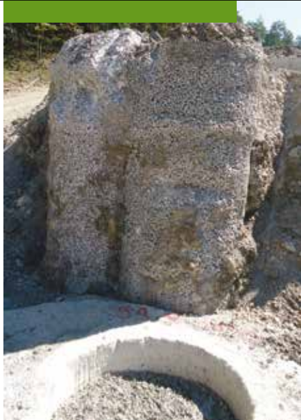
12. Vista della doppia fila di pali drenanti con calcestruzzo alveolare in corrispondenza del salto di quota altimetrico
